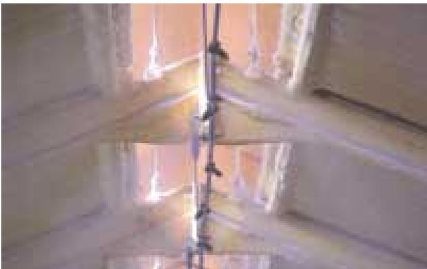
Consiste en pulverizar agua a alta presión en el interior del local formando una nube de gotas de pequeño diámetro, de forma que, cuando el aire exterior se introduce en el local, evapora las finas gotas, aumentando su humedad y disminuyendo su temperatura. Su mayor inconveniente radica en que, si no se vaporiza todo el líquido, el exceso de agua se deposita en forma de gotas en el interior.
