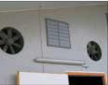
**La entrada de aire se realiza desde un extremo de la nave, mediante una amplia superficie de entrada de casi los 12 m. de ancho, provista de lamas de regulación independiente, lo que permite una amplia gama superficies de entrada en función de las necesidades.**
