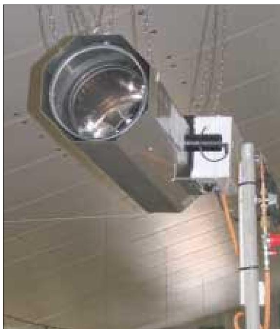
**Se utiliza un sistema generador de aire caliente a gas propano para ser utilizado los primeros días después del parto y una vez vaciada la nave como ayuda para el secado tras el lavado de toda la instalación.**
