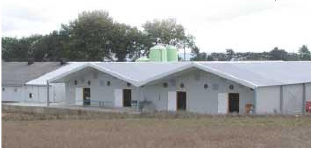
*La explotación consta de dos naves adosadas de 12 m de ancho por 45 m de largo cada una, con una estructura muy robusta de perfiles de acero y paredes de sandwich de 5 cm con dos chapas de acero lacado y espuma de poliuretano.*
