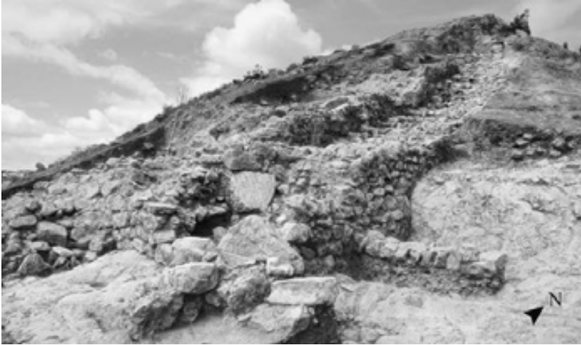
Lámina 3. Vista general desde el Este de la alcazaba del conjunto fortificado andalusí de cerro Calvario. En primer término la esquina oriental de la muralla de la misma, que encierra uno de los aljibes del sistema hidráulico, construida con mampostería y sillarejo sobre la roca natural recortada en época ibero romana. Obsérvese en la parte superior de la imagen los restos de la torre que ocupaba la cumbre del Calvario, protegida por un foso de perfil en V.
