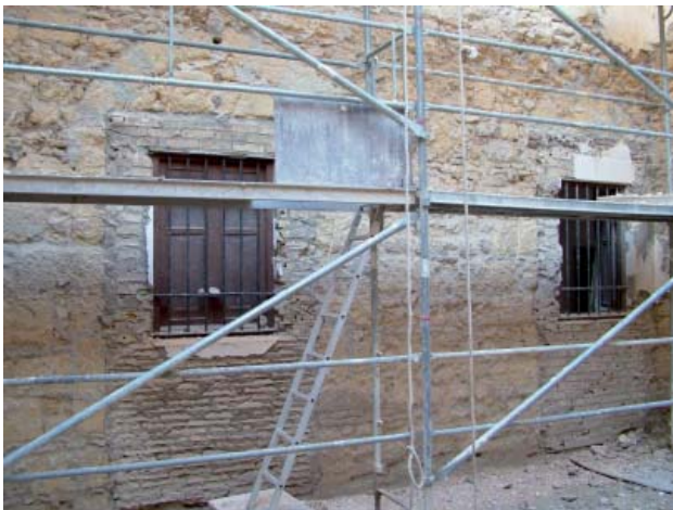
LÁM. V. MURO DEL S. XIX, CIERRE DE SUS VANOS EN EL S.XX.
