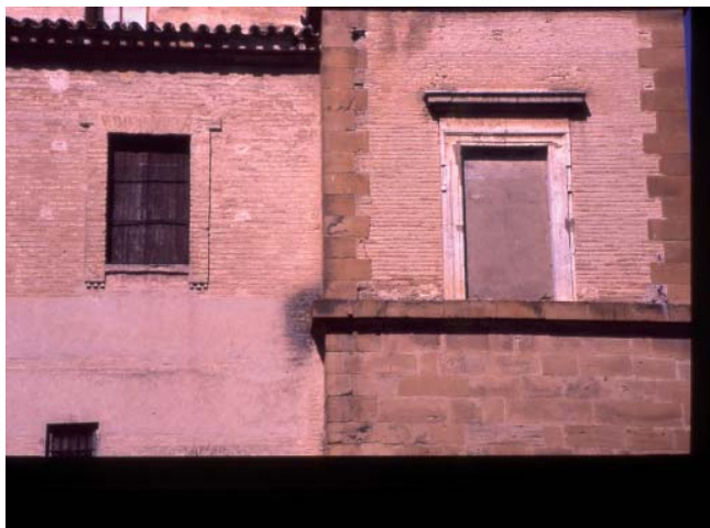
CONVIVENCIA DE LA ALBAÑILERÍA ANDALUZA Y LA CANTERÍA CORTESANA
