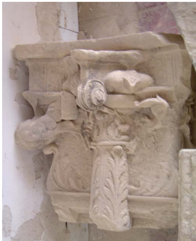
CAPITEL DE LA PILASTRA MUY MUTILADO, CON AVES EN LAS ESQUINAS SUSTITUYENDO LAS VOLUTAS DEL ORDEN CLÁSICO
