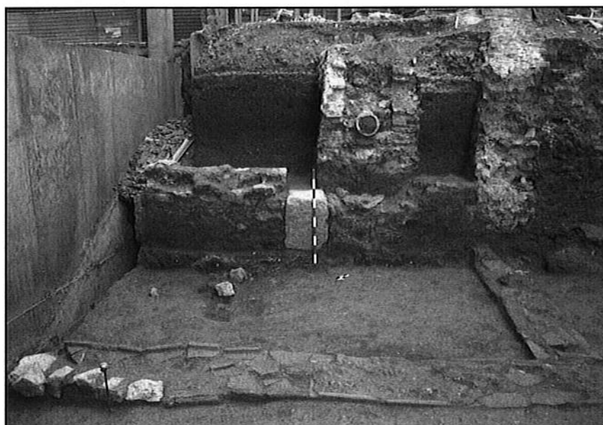
Lámina 4. Detalle de la técnica constructiva de los muros de las habitaciones nº 1 y 2 (foto: L. Suárez).
