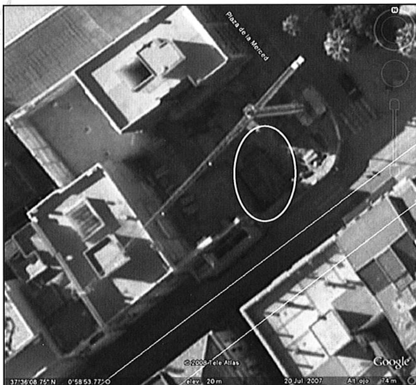
Lámina 2. Vista aérea de parte de las estructuras de época romana (montaje: L. Suárez).
