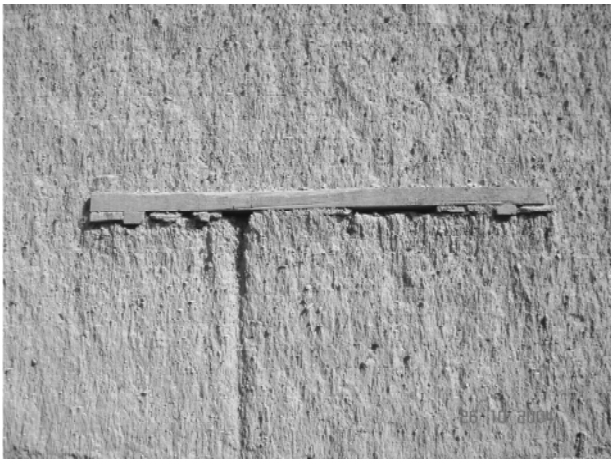
Muro de tapial con poste de madera embutido
