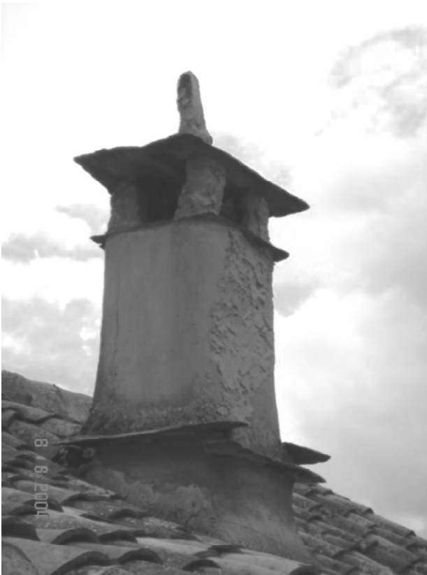
Chimenea casa Mallo. Castrillo de los Polvazares
