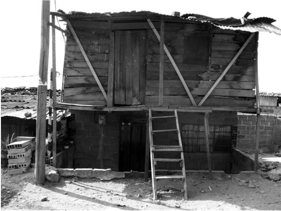
Figura 2. Vivienda El Morro.
