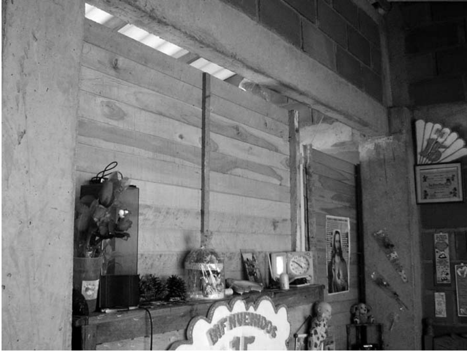
Figura 52. Técnicas primarias implementadas en la reforma de las viviendas.
