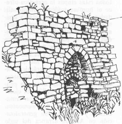
Horno de Uncastillo: vista del frente y boquera cámara de combustión. Se construyó aprovechando el declive natural con la fogaina excavada y la puerta de carga en alto. De bóveda abierta.
