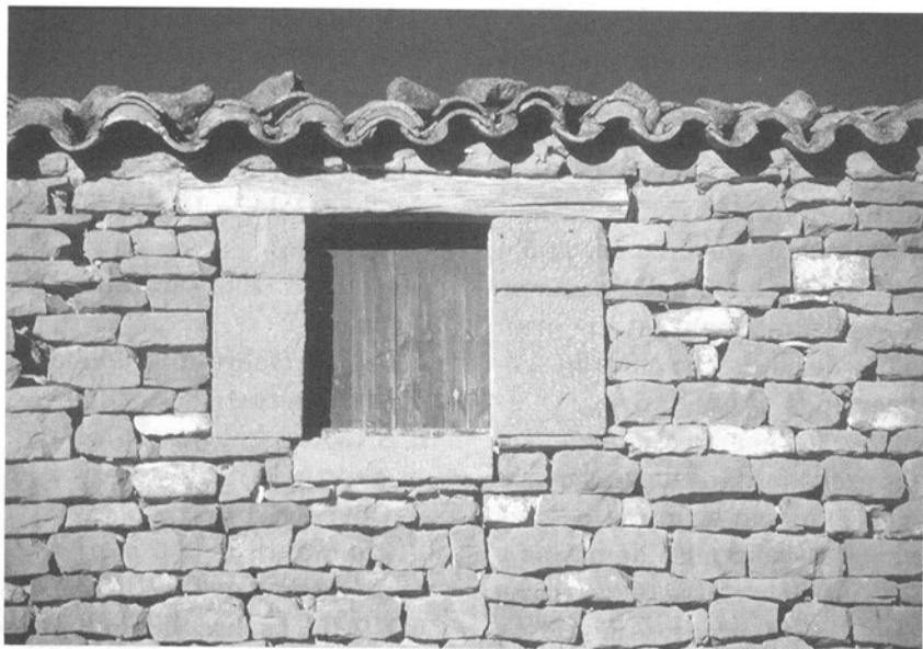
Fig. 11. Ventana de la casa en el Corral de la Huerta (Uncastillo).
