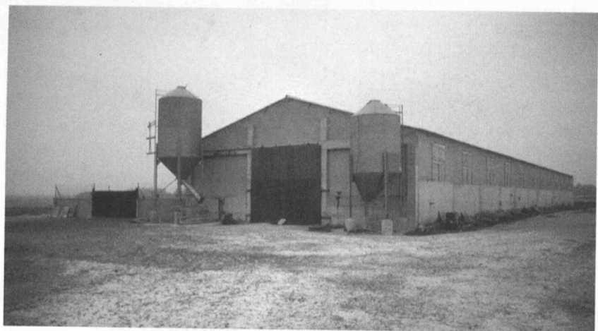
Fig. 19. Nave en el Corral de San Gil (Ejea).
