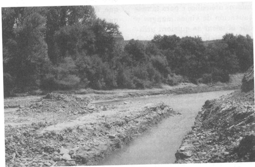
Fig. 17. Obras de construcción de una minicentral hidroeléctrica en La Zaida (Zaragoza) en 1998, donde se hallaron restos de una población de M. auricularia . Foto: Archivo Josu Herce, 1998; con autorización.
