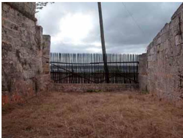
FIGURA 7. Área de trabajo antes de la intervención
