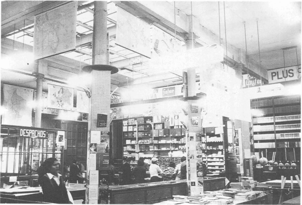
Fig. 10. Estructura metálica en el interior de la Librería «Arnó Hnos.». Tipo de edificio comercial propio de una firma catalana.
