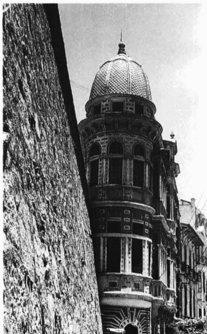
Fig. 5. La avenida Montes, en primer plano el muro que salva el desnivel de dos vías. Una vivienda propia de este sector donde trabajó activamente la empresa Llombart.
