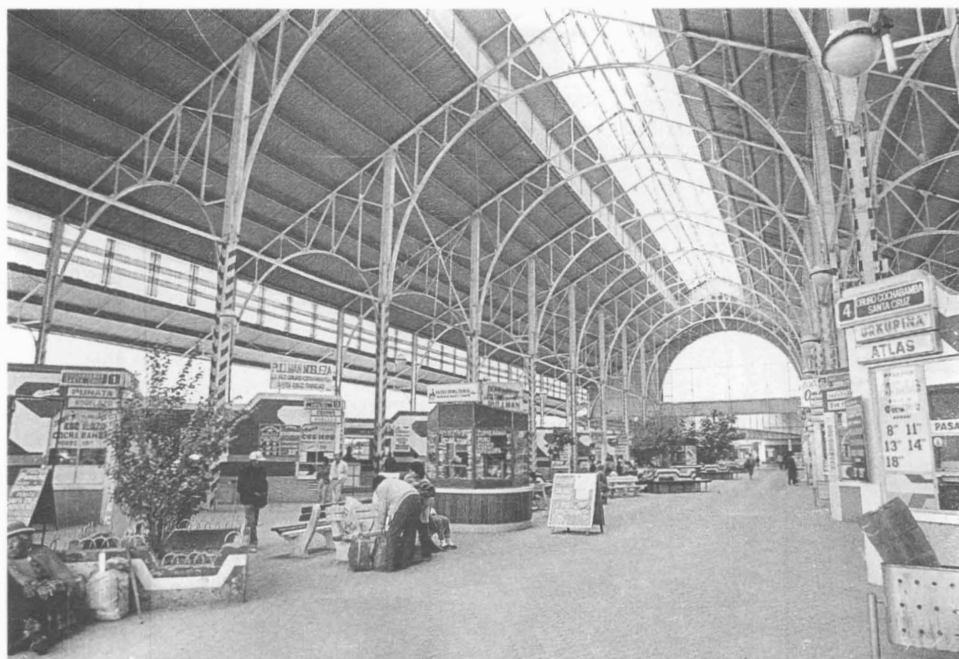
Fig. 7. Interior de la Estación Guaqui-La Paz cuya estructura fue realizada por la firma Carnegie de Pensilvania, contruida en su emplazamiento por Miguel Nogué. El diseño fue hecho en París, en el Estudio de Eiffel.
