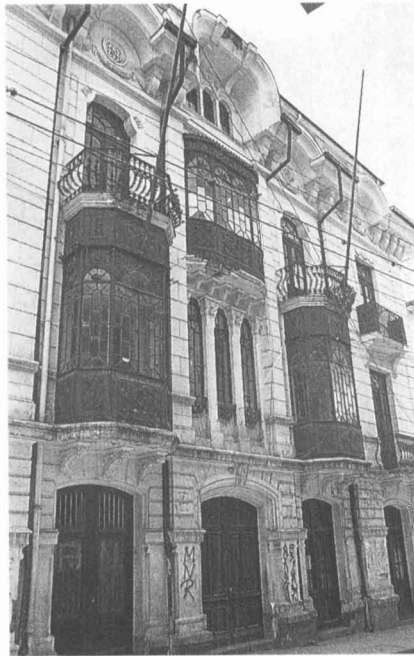
Fig. 14. Casa con «farolas» de hierro forjado, característica de la arquitectura de los años 20.
