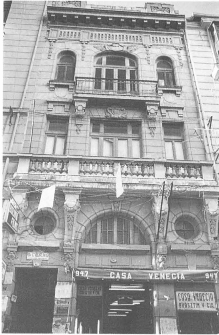
Fig. 9. Casa construida por la empresa Ramón Llombart. Calle Comercio. La Paz.
