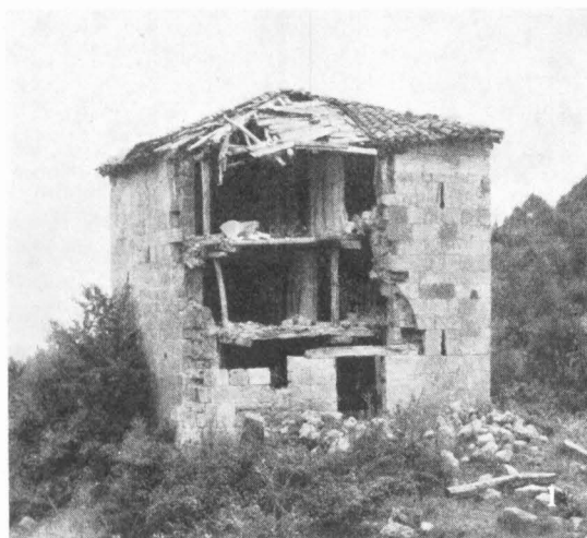
Foto 1. Restos de la torre llamada de los Infanzones de Ojeda, construída inicialmente en el siglo XIII.
