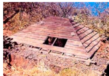
El "forro", antes de poner las tejas, añade calidad a la cubierta.
