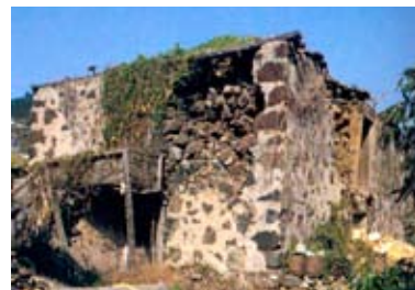
Muros de mampostería con lienzos y esquinas “careadas” y rellenos.
