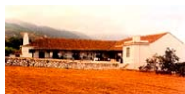
Casa terrera en L de sorprendente modernidad.
