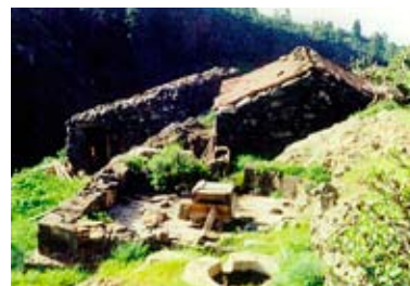
Casas de arrimo, con aljibe y “coladera”, para guardar y decantar el agua de las escorrentías.
