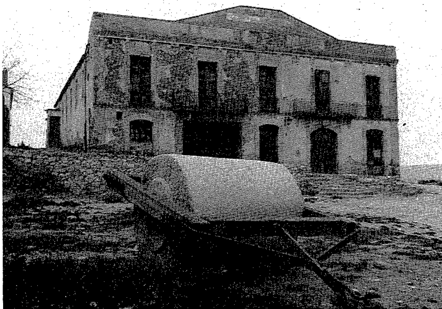
Edifici de "La Societat" en el seu estat actual. Futur Museu de Cooperativisme Agrari.
