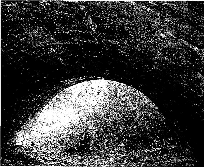
Pont de Sant Bernat
