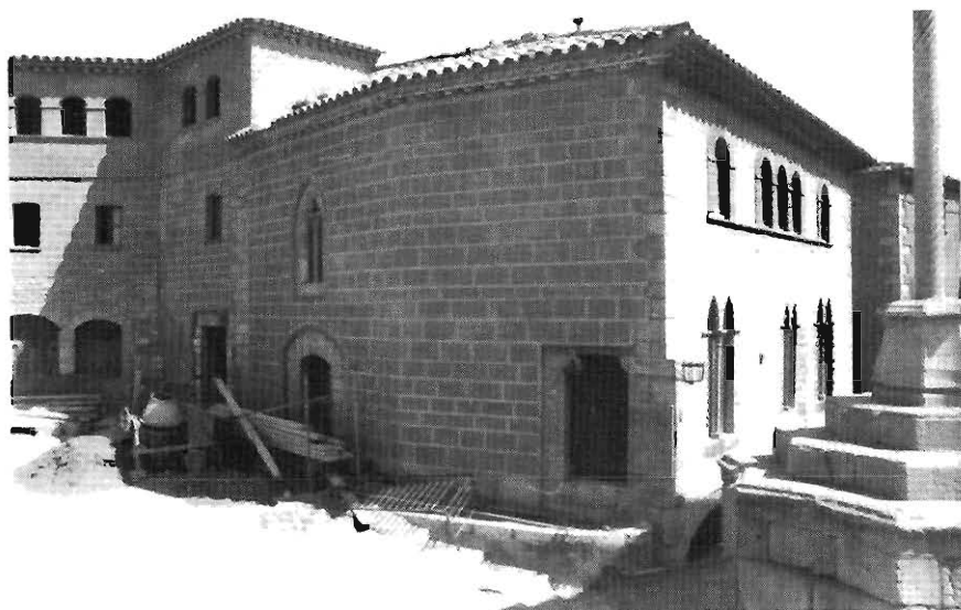
Fig. 62.- Façana posterior, durant les obres de l'esgrafiat l'any 1986.
