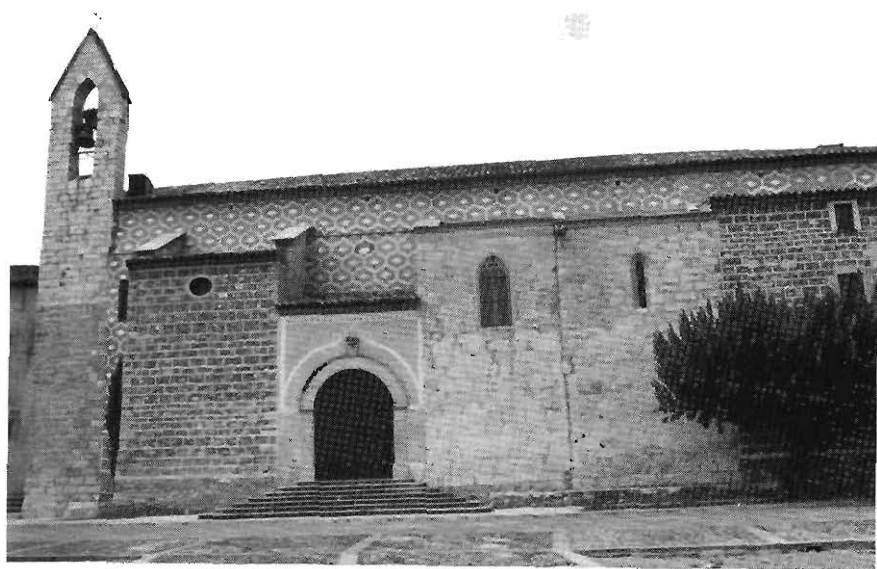
Fig. 65.- Convent de la Serra. Obra de restauració l'any 1988.
