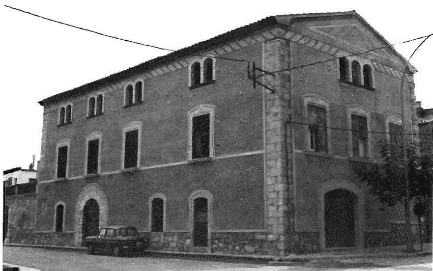
Fig. 84.- (8.3) C. Miquel Alfonso/Avgda. Manuel Ribé. Ca la Sireta. Obres de reforma l'any 1990.
