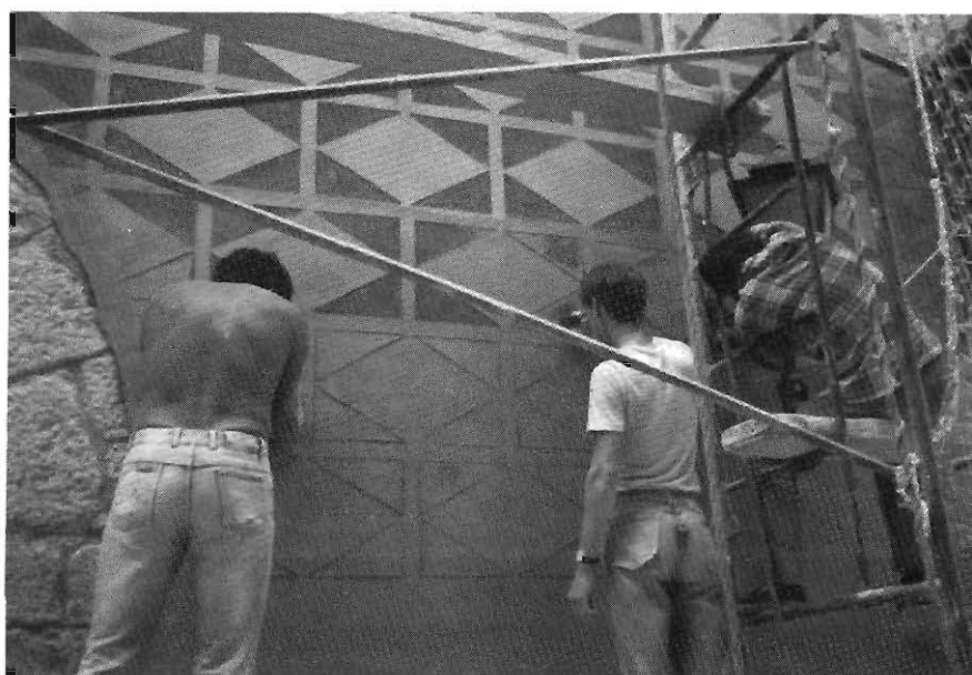
Fig. 74.- A dalt, aplanillat del dibuix; sota, rascat dels contorns.
