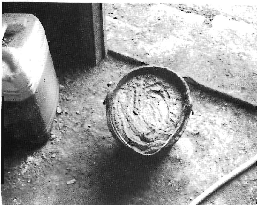
Fig. 76.- Preparació del morter de calç.
