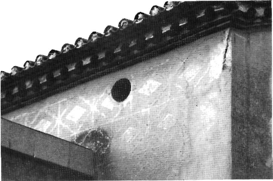
Fig. 60.- Detall de la façana lateral.
