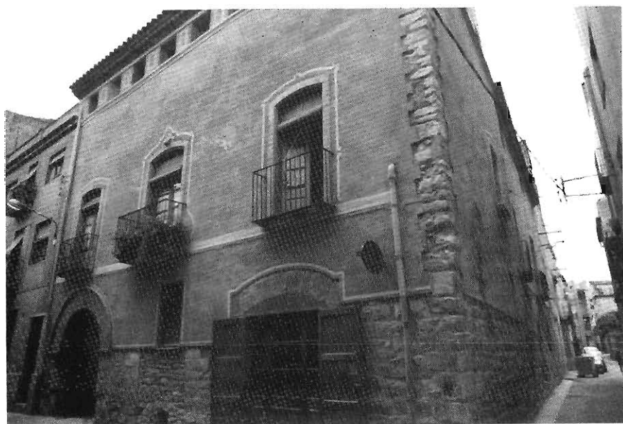
Figs. 82 i 83.- Façana principal i detall del balcó central.
