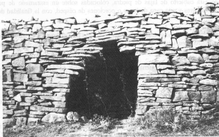
Fot. 2 – Casetón en la pared, con aproximación irregular de hiladas.
