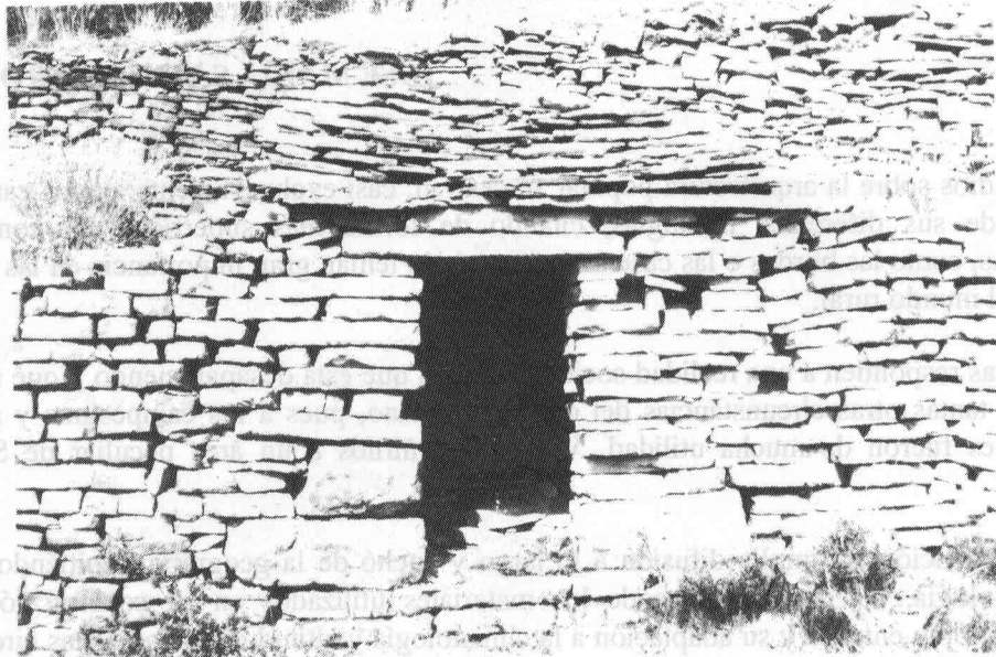
Fot. 1 – Casetón o hueco en la pared, con tejado.
