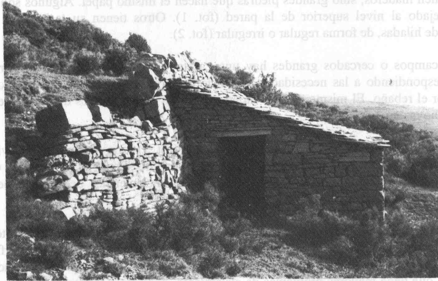
Fot. 3 – Caseta adosada a una pared.
