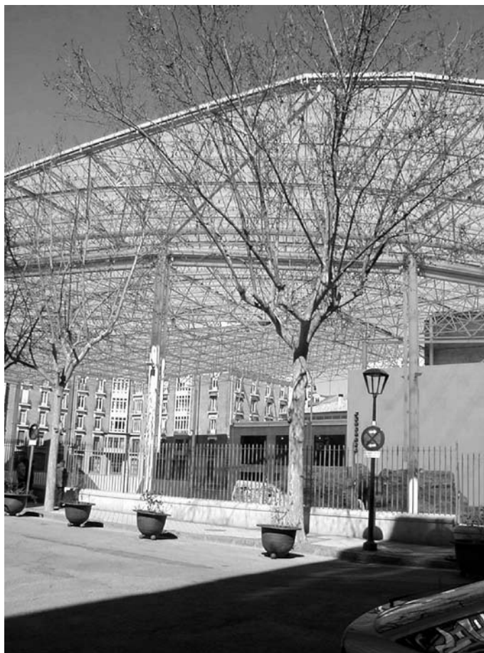
Fig. 11. Cubrición del Teatro Romano en Zaragoza (Fotografía del Autor)
