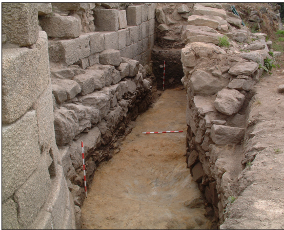
Fig. 13 Detalle da muralla na zona S
