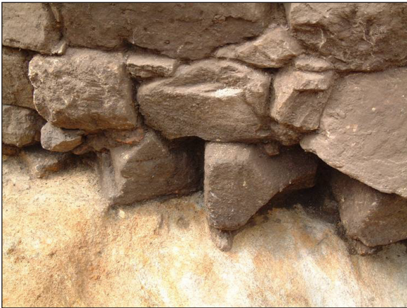
Fig. 21 Elementos arquitectónicos reaproveitados na barbacá S.
