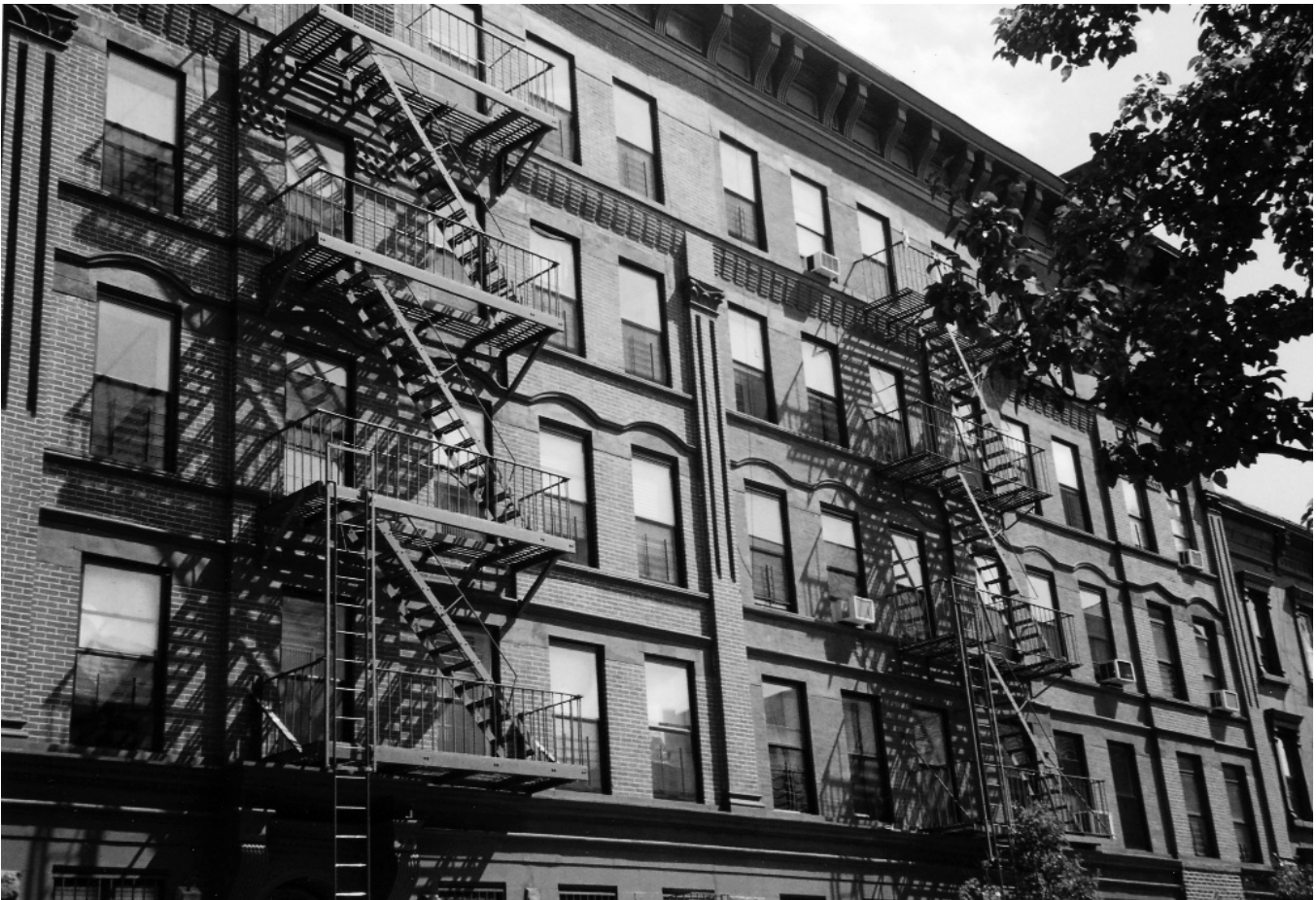
Harlem, edifici rehabilitat
