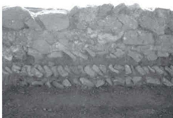
Lám. 43.: Detalle de la edificación del muro exterior de la basílica (a partir de BOTELLA-SÁNCHEZ, 2008).
