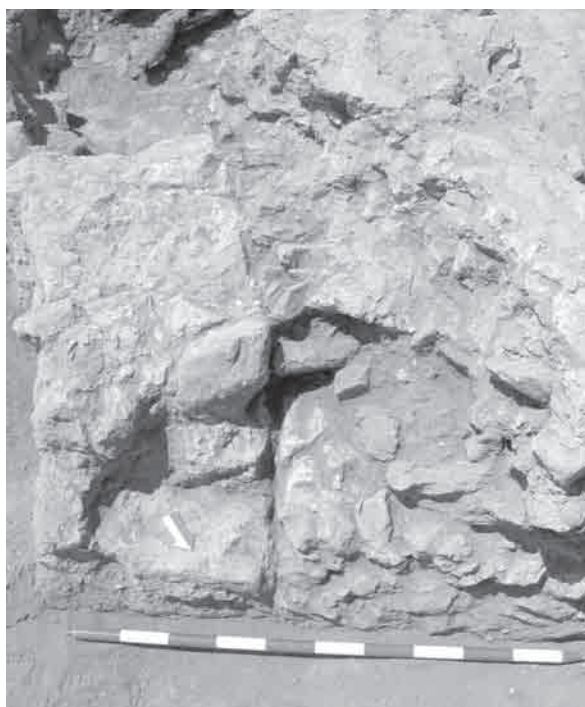
Lám. 44 a y b.: Adosamiento del banco corrido a la estructura del ábside occidental (BOTELLA-SANCHEZ, 2008).
