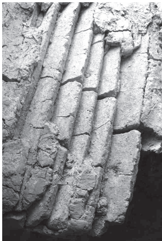
Lám. 13: Horno 1. Cámara de combustión. Detalle de los arillos de tejas dispuestos entre los arcos de ladrillo.
