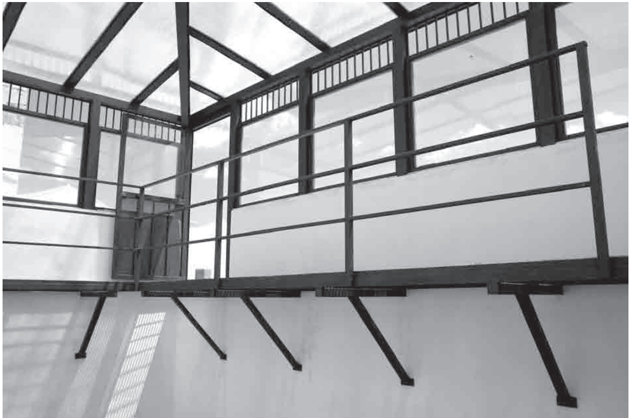
Lám. 22: Detalle de la cubierta de protección de las estructuras.
