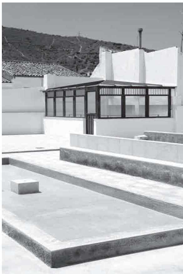
Lám. 23: Cubierta de las estructuras de los hornos en el contexto de la plaza donde se ubica.
