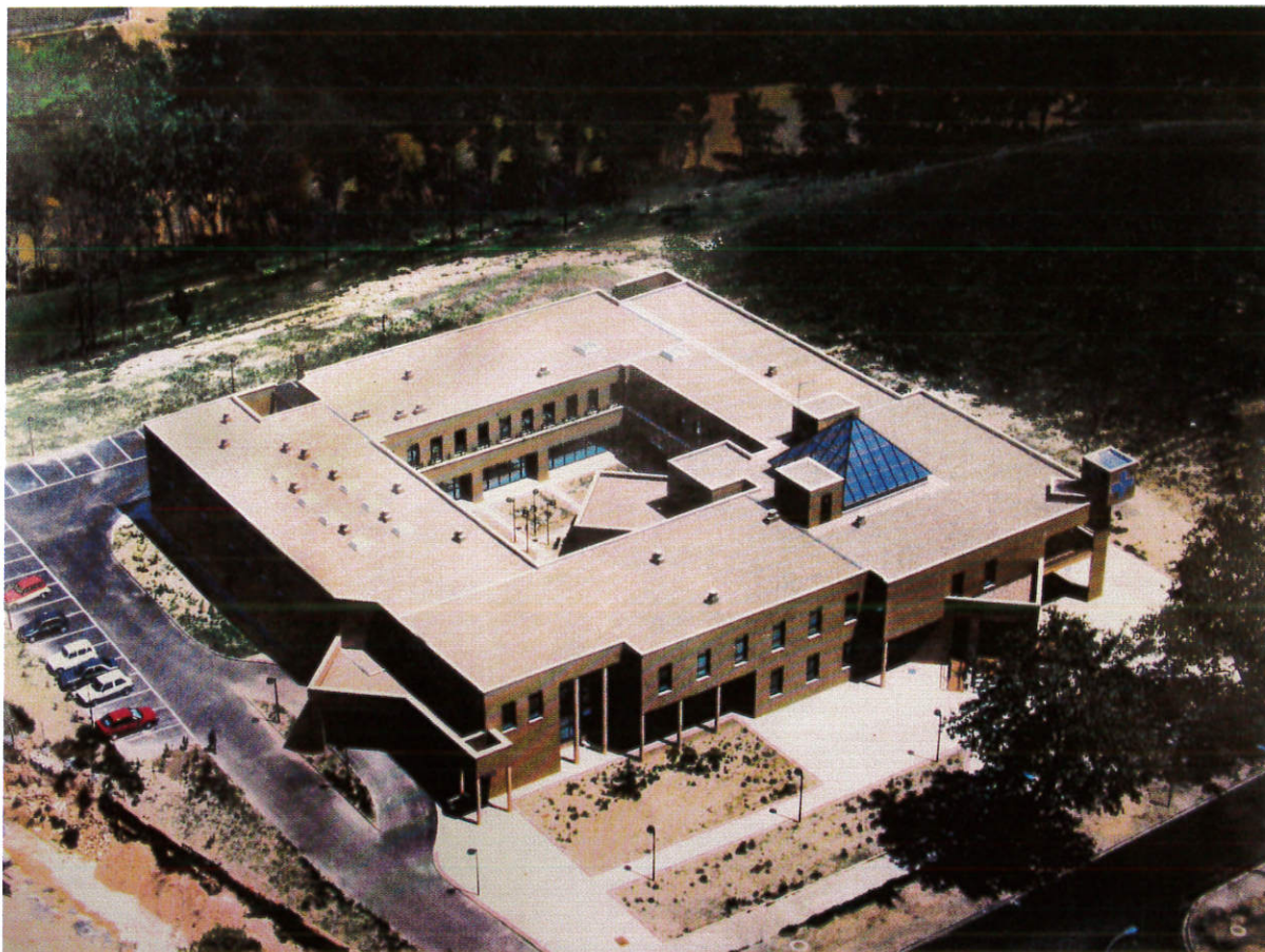
Fig. 25. Aranda de Duero. Centro de Salud «Aranda Sur».
