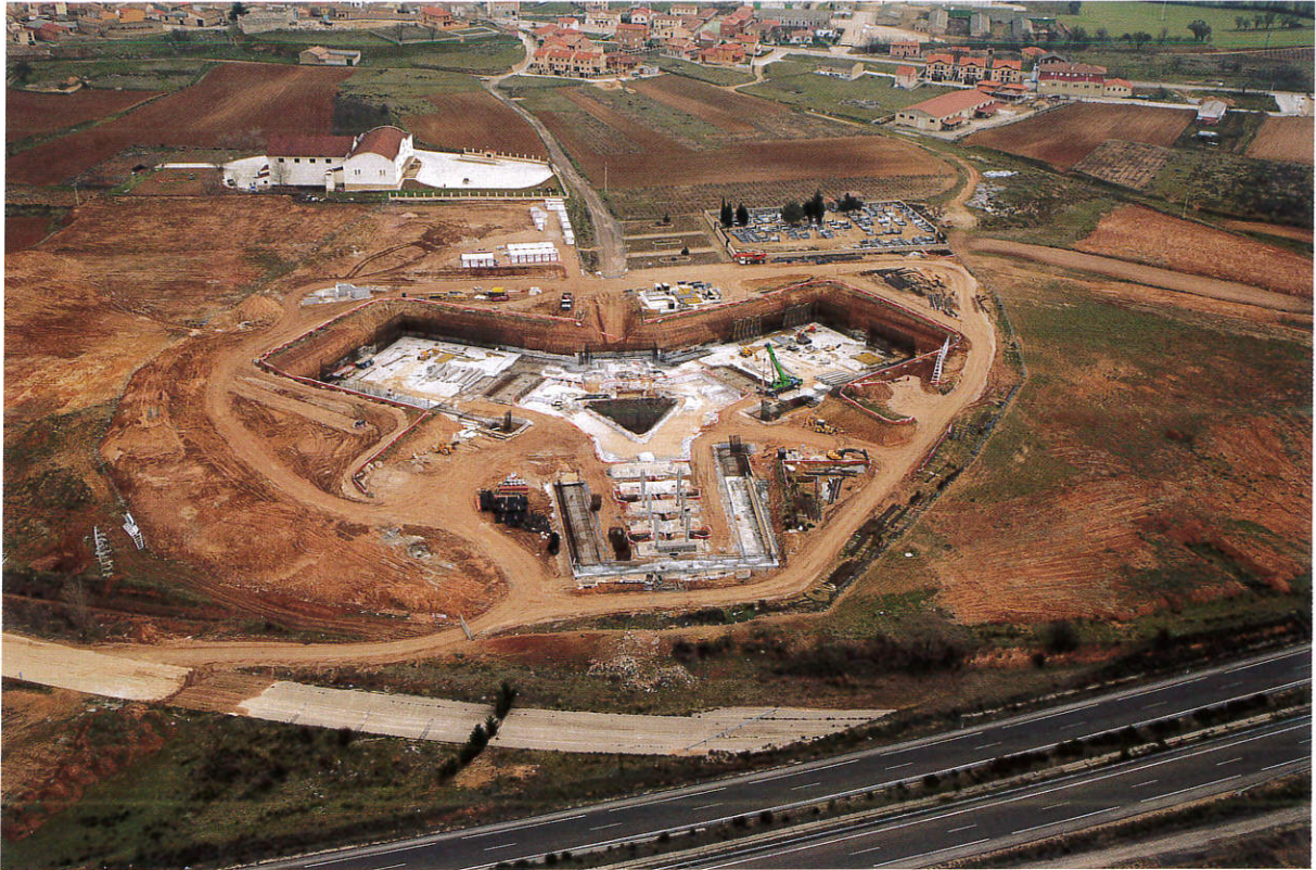
Fig. 26. Gumiel de Izán. Proyecto en construcción. Arq. Norman Foster (Fotografía Merlín).
