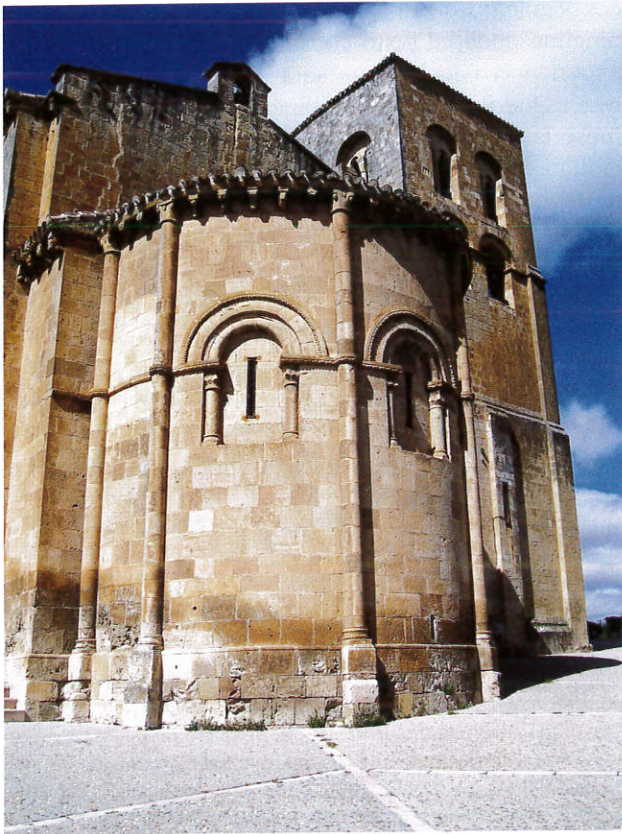
Figura 5. Vista del ábside y la torre de la iglesia de San Salvador de Sepúlveda, villa a la que, según los expertos, Alfonso VI concedió su fuero en 1076
