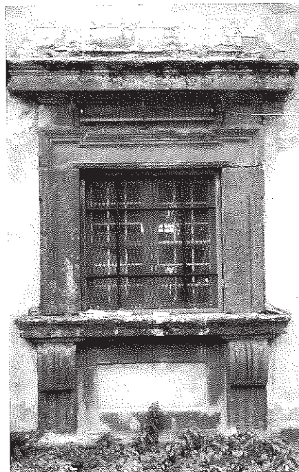
15. Una de las ventanas del lado occidental, en el interior del patio, recolocada por Busiri Vici
