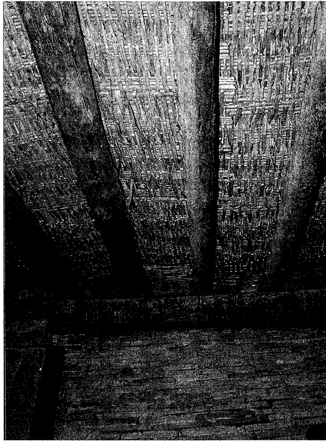
Foto 10: Detalle de un entramado de cañizo
