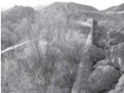
Lugar de construcción del tablero original del Puente del Salado.
