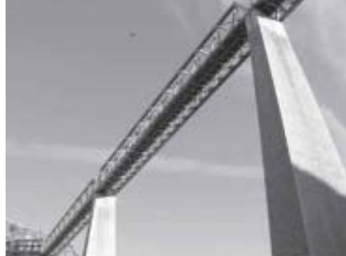
Vista del Puente del Salado desde el pie de la pila del lado de Linares.
