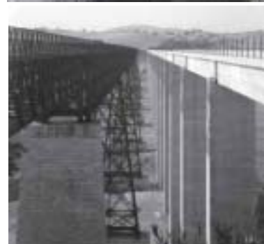
Vista del Viaducto del Hacho desde el lado de Almería (junto a la Estación de Alamedilla).
