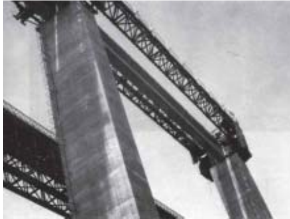
Detalle de lanzamiento de las vigas de hormigón pretensado.
