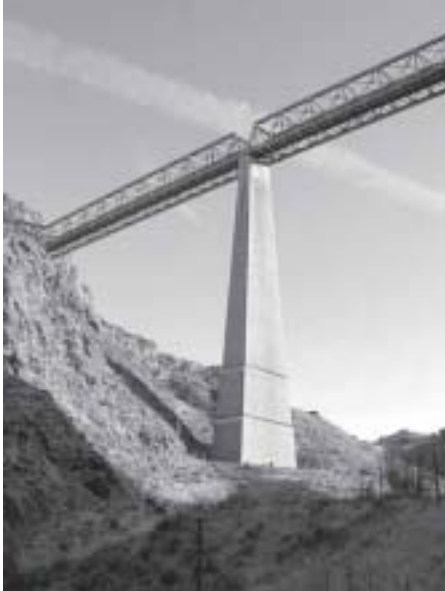
Vista desde el fondo del cauce de la pila del lado de Almería en la actualidad.
