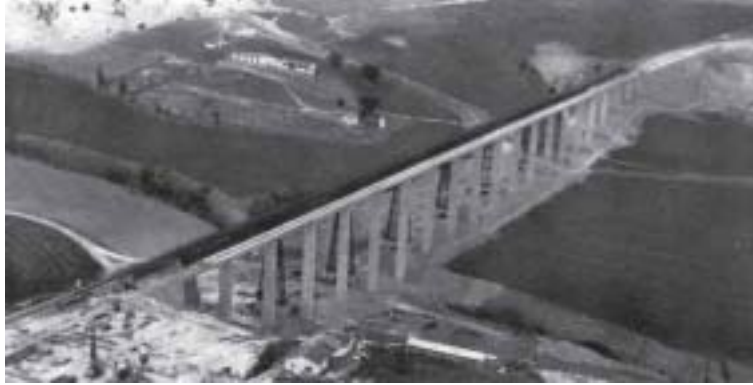
Vista aérea del nuevo viaducto durante su construcción
