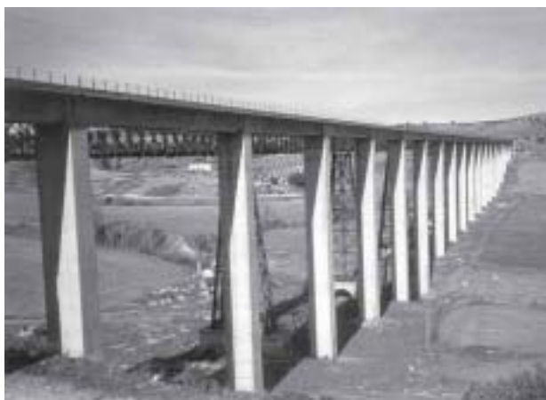
Vista actual del nuevo Puente del Hacho
