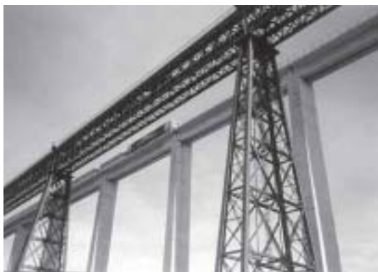
Puente del Hacho. Talgo cruzando el puente de hormigón,
