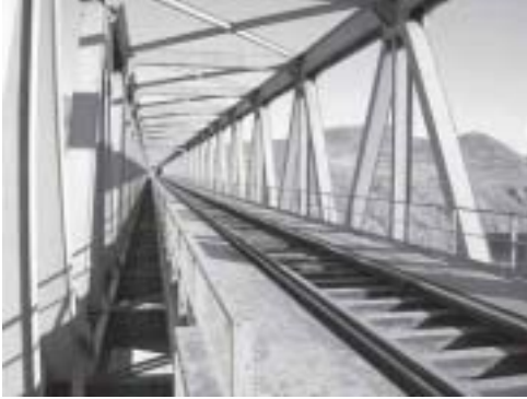
Detalle del tablero metálico actual.
