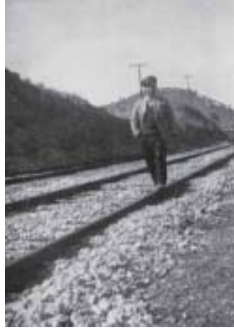
Inspeccionando la vía. Años 70.
