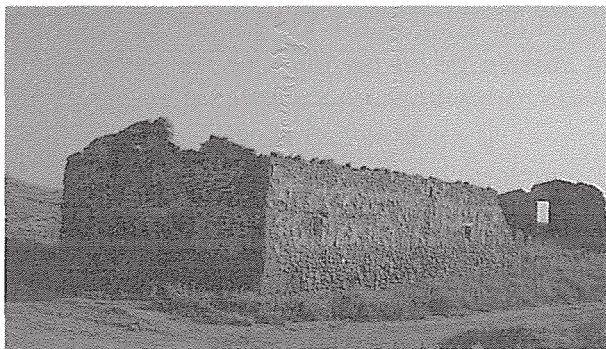
Estado actual de la venta del Pillo, construida de mampostería y con piedras isódomas reutilizadas del antiguo monasterio de Santa María de Niecebas. Este fue un lugar estratégico para el comercio ilícito en la frontera castellano-navarra, donde —además— se ofrecía cambio de postas (35).
