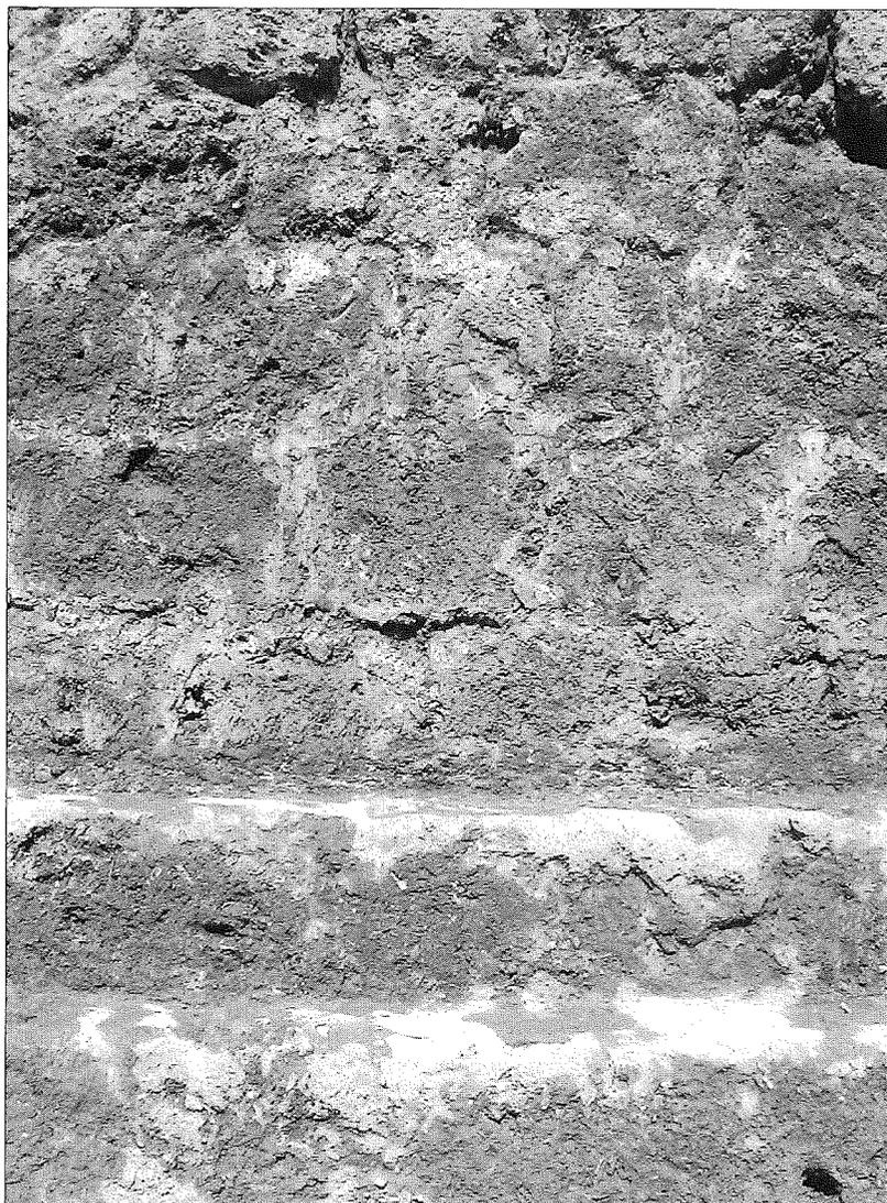
*Detalle del antemuro II, con fábrica de sillarejos del travertino llagueados con mortero de cal. En la parte inferior del paramento, la zarpa escalonada.*
