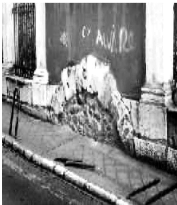
Arco de la presa que pasaba San Isidoro. Actualmente está tapado.
