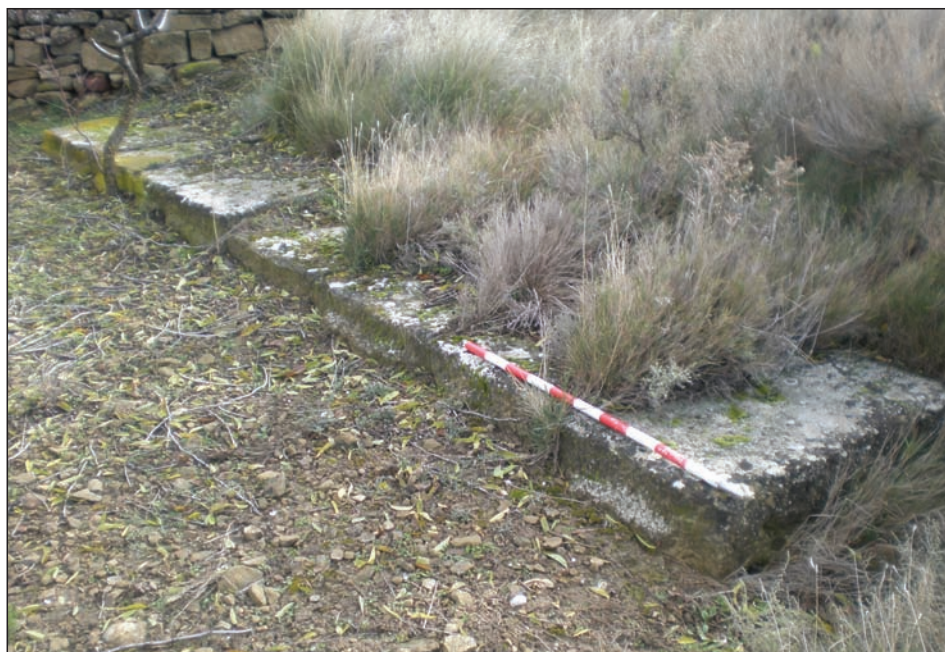
Figura 9. Cimentación del posible mausoleo funerario romano de Sonavilla/Cabaña del Gacho, en Castiliscar (foto: P. Faus)
