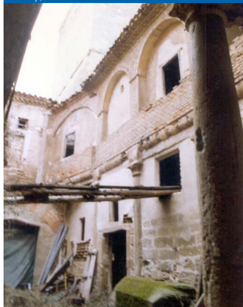
Interior, cuerpos añadidos. (Columnas Toscanas), antes de la restauración.
