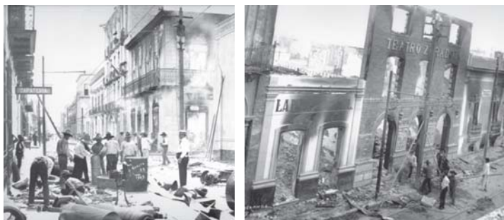
Incendio de la calle Morelos, izquierda; y del Teatro Zaragoza, derecha.
