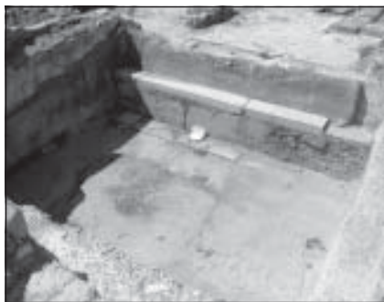
Lam. 8: Piscina de agua fría
