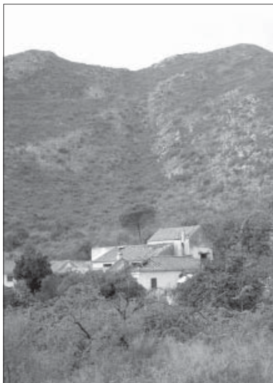
Estado actual de los edificios de "Puerto Rico Bajo" (Foto: Lucía Prieto Borrego)
