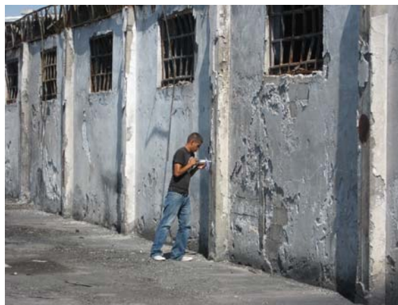
Figura 10 Uso del esclerómetro para obtener el esfuerzo f'_c de las columnas y de la dala de cerramiento
