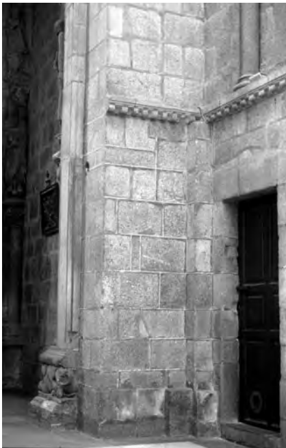
Fig. 5. Rincón noroeste de la nave de la catedral.
