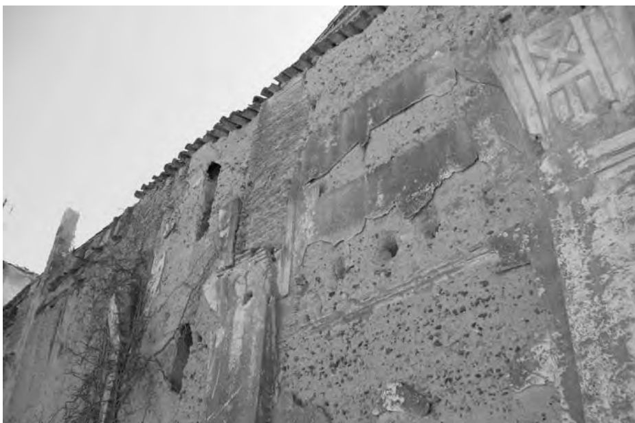
Fig. 1. Restos conservados del convento de San Miguel y Santa Isabel. (Foto Lorena García García).
