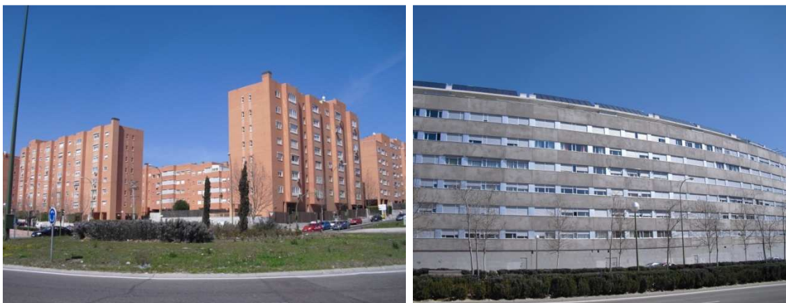
Fig. 15 y 16. En la primera imagen se observa el típico bloque de pisos con un alto desarrollo en altura realizado con ladrillo. La segunda refleja un bloque de hormigón con menor estética que en el caso anterior. Fuente: Fotografías propias.
