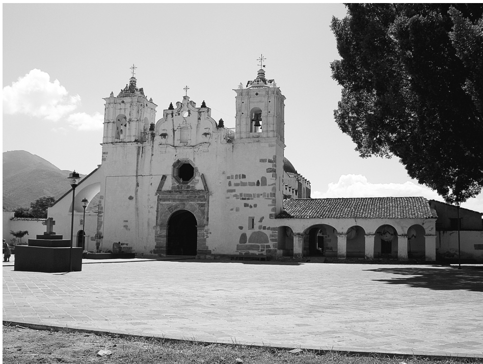
Fig. 6.—Teotitlán del Valle, Oaxaca: en la construcción de la iglesia, claustro y capillas posas se emplearon piedras de edificios prehispánicos.
