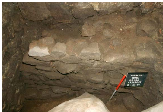
Figura 5: Rua da Penaventosa, 25-27. Alçado da face interna de um troço de muralha romana (Foto: CMP/GAU)
