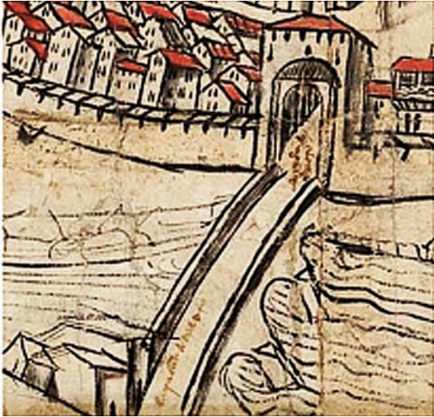
Fig. 9. Puente y puerta de Duero.
