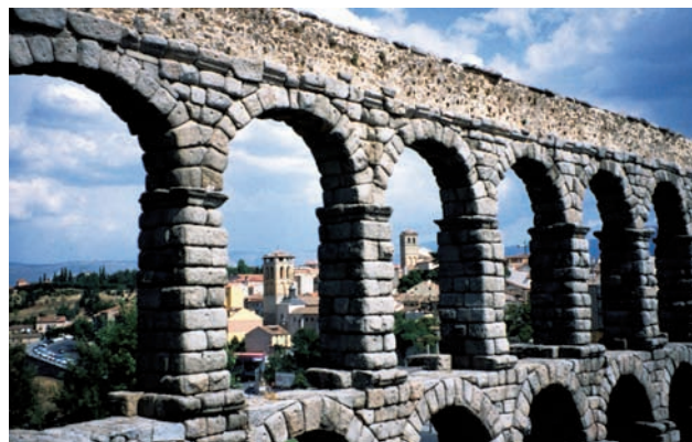
Acueducto de Segovia. Foto J. I. Sánchez.
