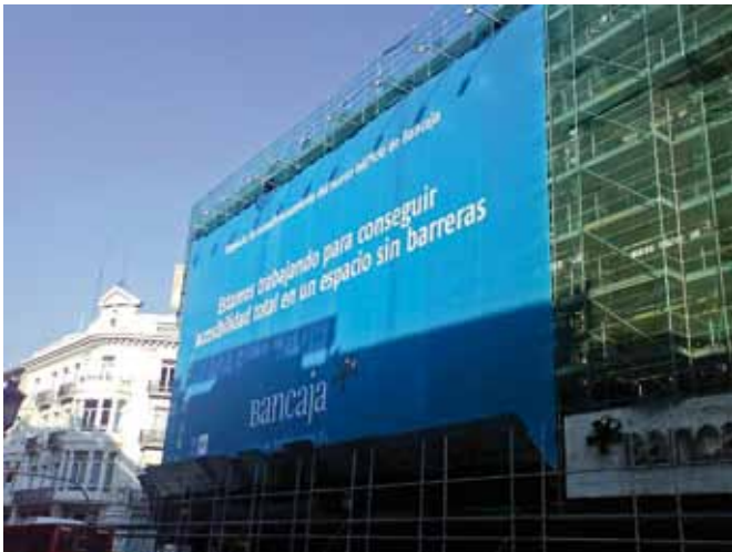
Figura 1. El edificio BANCAJA Sorolla en un momento de la reforma.
