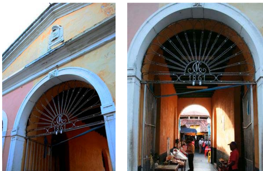
Figura 1 y 2: Detalle de la construcción y Entrada a la Feria de Praia Grande o Casa das Tulhas
