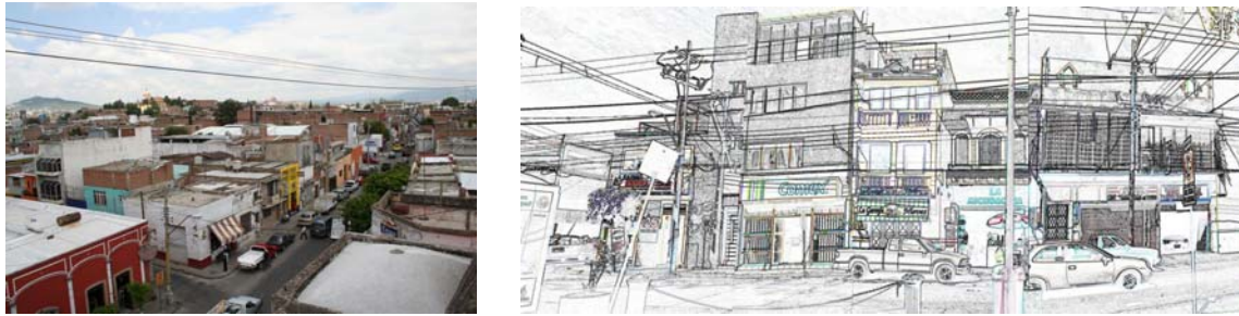
Imágenes 8-9. Vista panorámica hacia el Nor-Este, Calle Constancia y fachadas hacia la Plaza sobre la calle 27 de sep. La falta de normas preventivas que regularán el crecimiento de la industria, en los años Ochenta ocasionando un deterioro de la infraestructura y la imagen armónica lograda en años anteriores.
